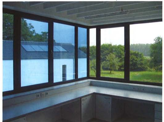
Bild 6. Schaltbares Sonnenschutz-Isolierglases in einer Schule [6] (Bilder 1, 3, 5, 6: EControl-Glas GmbH & Co. KG, Plauen)
